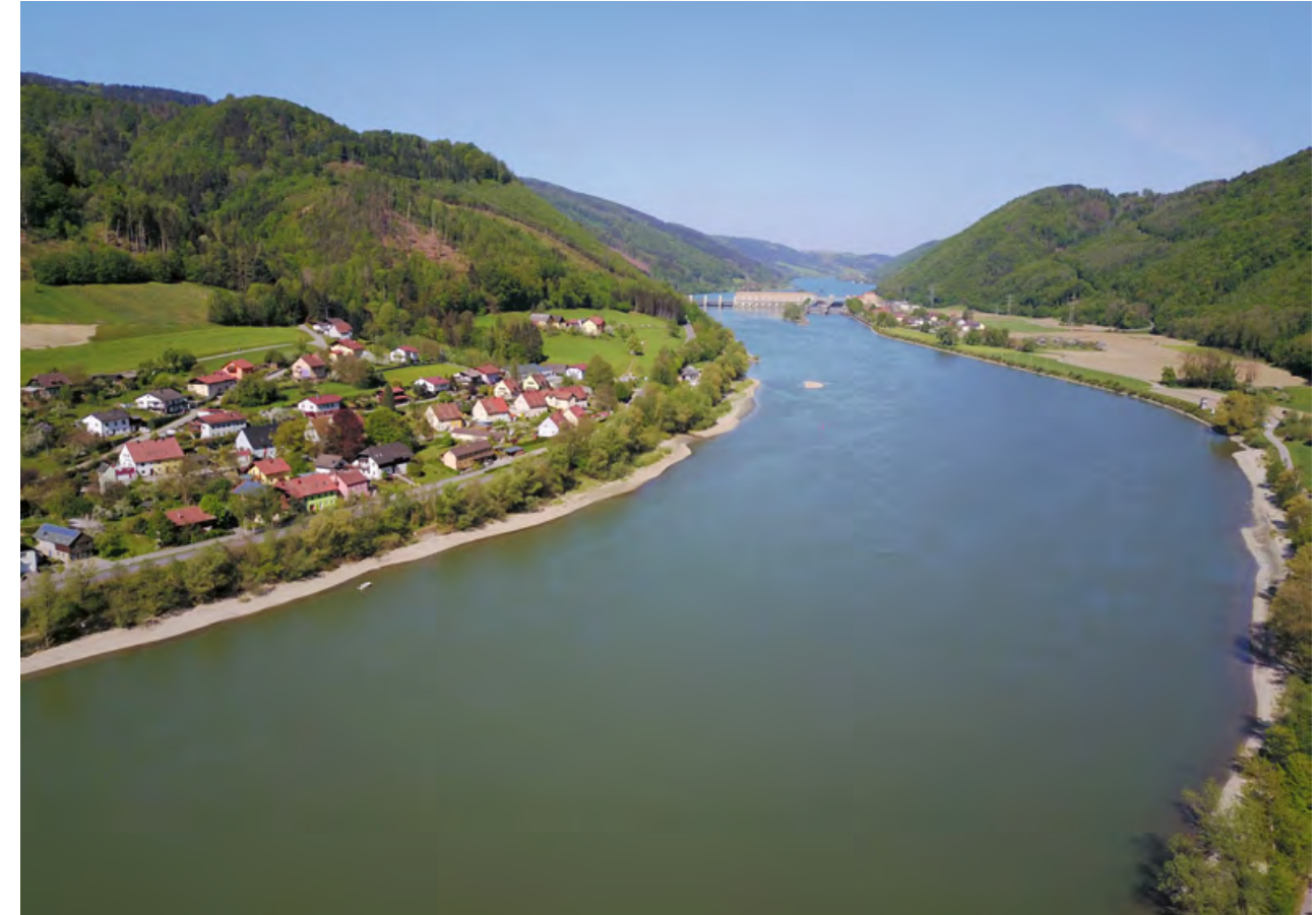
Abb. 11: Ehemals mit monotonen Blockwürfen ausgeformte Ufer können mit mit Vorschüttungen in Form von Kiesbänken und Inseln ökologisch aufgewertet werden. Hier, in der obersten Stauwurzel des Kraftwerks Aschach, wurde das gesamte österreichische Ufer umgestaltet. Das hart regulierte Ufer liegt auf deutschem Hoheitsgebiet (rechts hinten).
