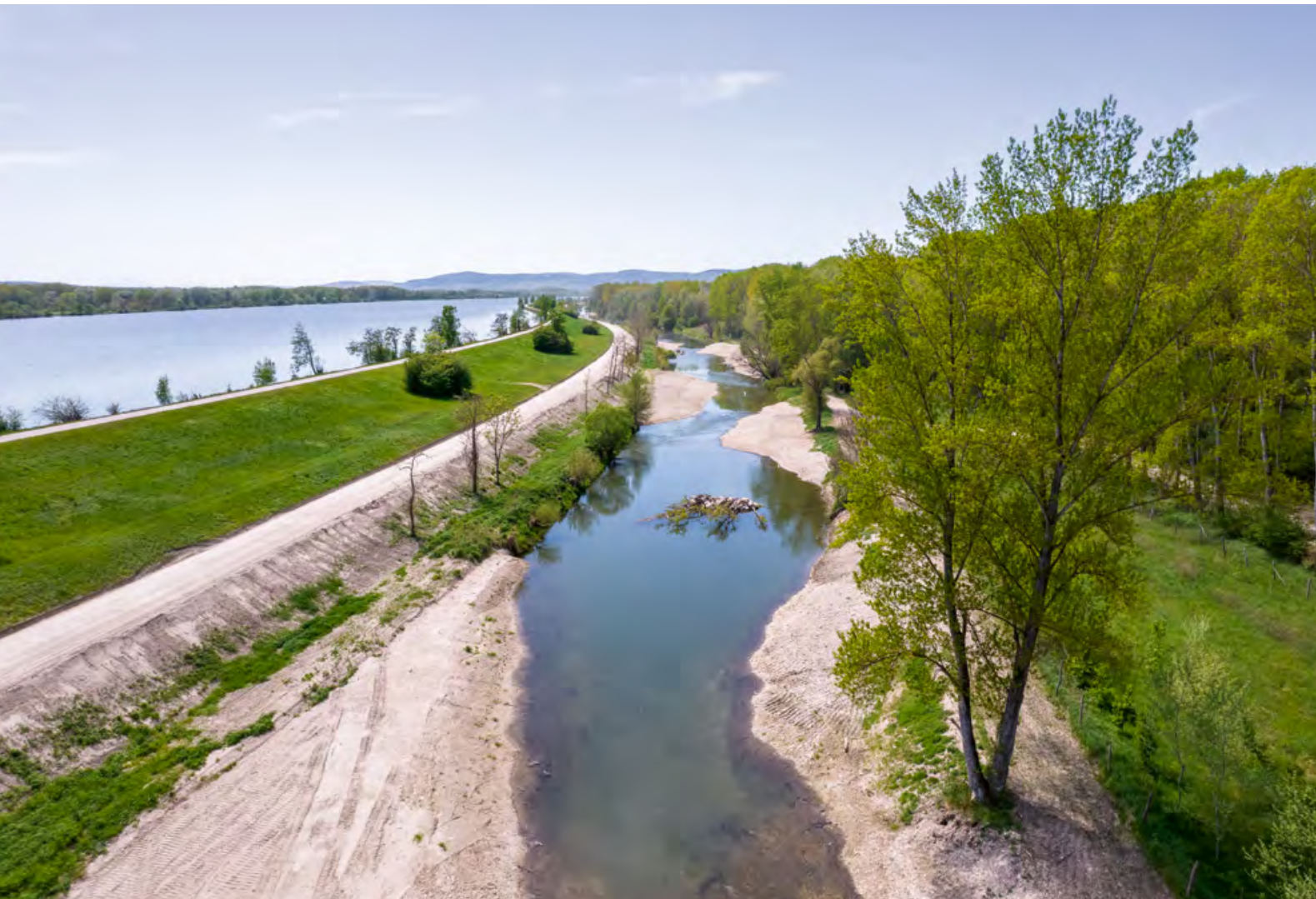
Abb. 3: Neugestaltetes Kremsgerinne mit Aufweitungen und Kiesstrukturen, Blick stromaufwärts.
