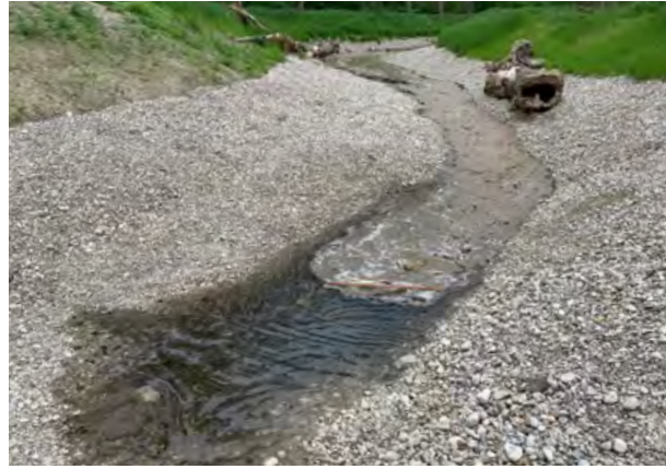
Abb. 8: Flutung des fertiggestellten Gerinnes im Frühjahr 2020.
