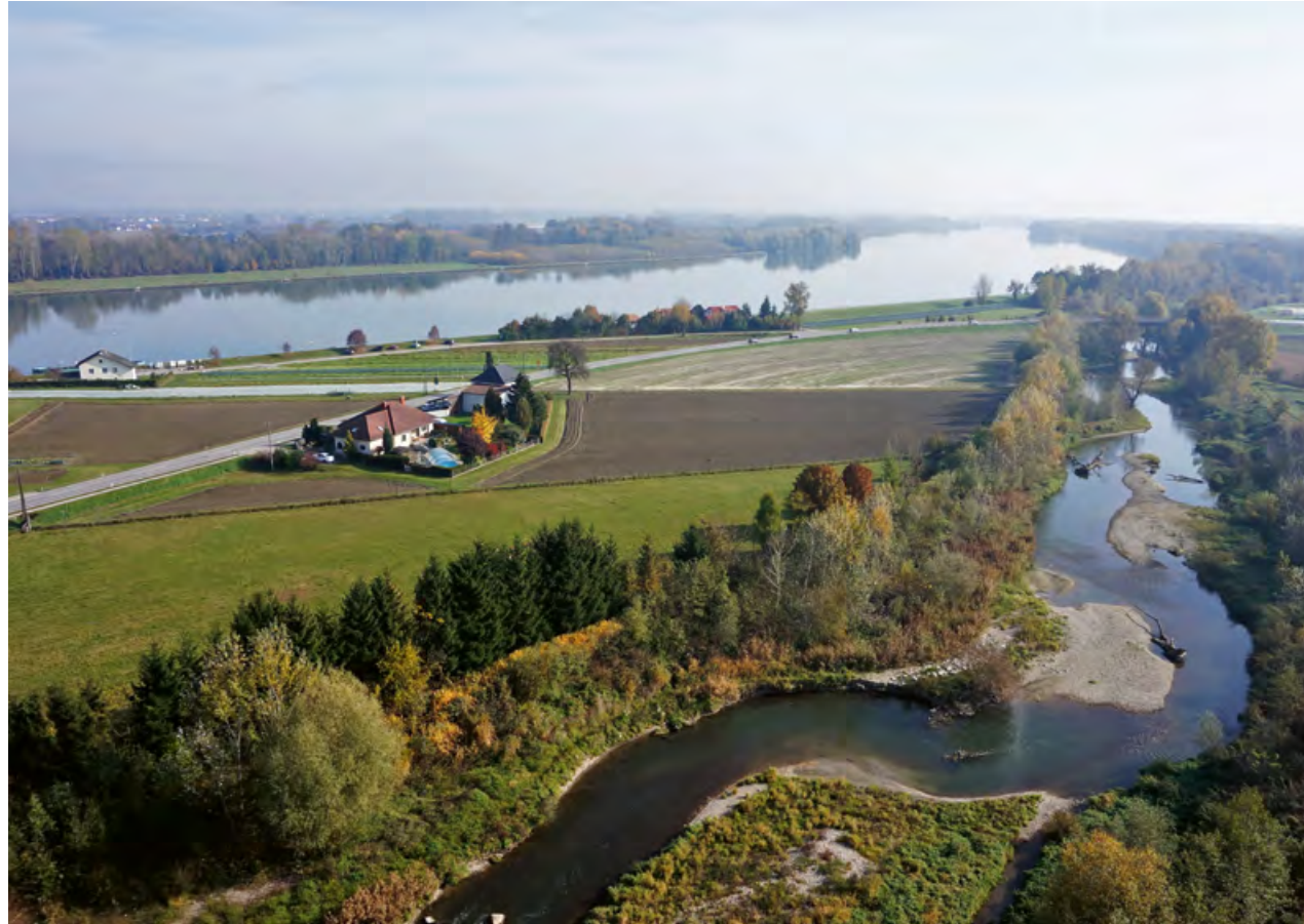
Abb. 10: Die Dotation der abgedämmten Aubereiche ist mit Hilfe von Umgehungsgewässern, die auch als Fischaufstiegshilfen fungieren, möglich. Ein mehr als 14 km langes barrierefreies Umgehungsgewässer bietet am Kraftwerk Ottensheim-Wilhering der rheophilen Fischfauna wertvolle Ersatzhabitate.
