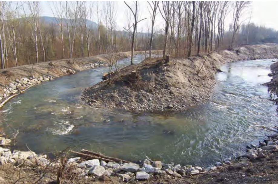
Abb. 6: Schleife der Fischwanderhilfe Melk knapp nach Baufertigstellung.
