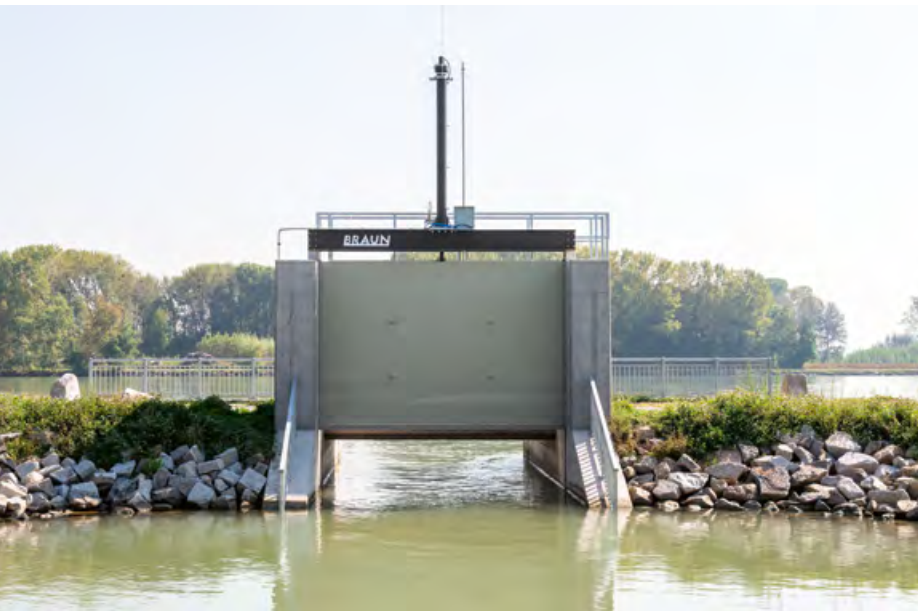
Abb. 4: Oberes Einlaufbauwerk und Ausstieg für die Fische in die Donau. Im Normalbetrieb ist es vollständig geöffnet, die Dotation wird somit nur vom Donauwasserstand beeinflusst.
