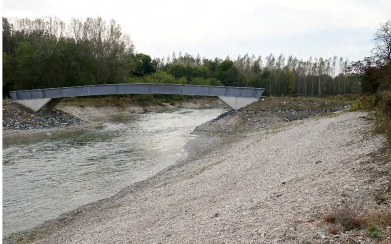
Abb. 3: Die Fahrradbrücke des Donauradweges über den neu gestalteten Flusslauf der Traisen – nach Errichtung der Brücke im Jahr 2016.
