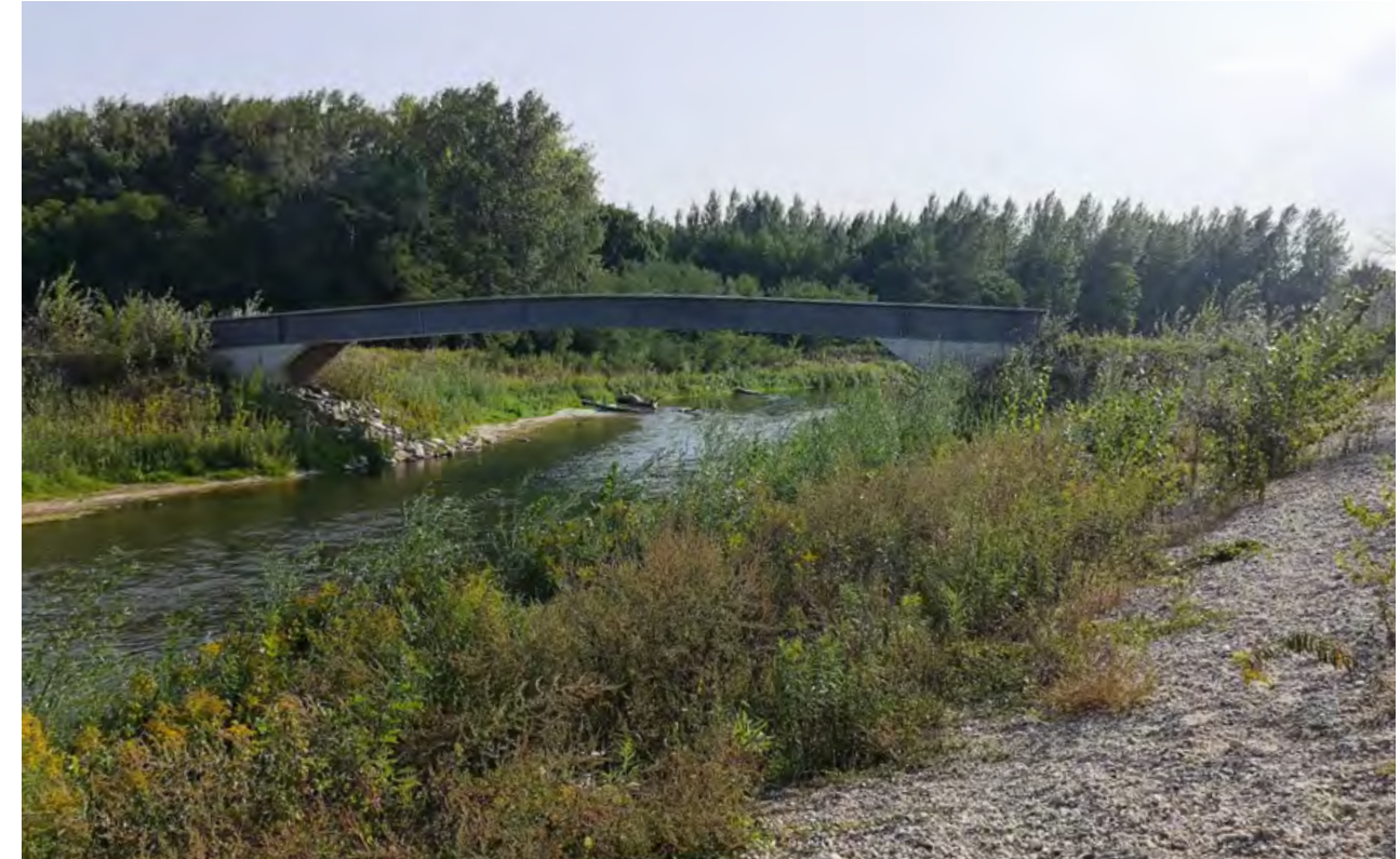
Abb. 4: Derselbe Standort des verlegten Donauradweges, drei Jahre später.
