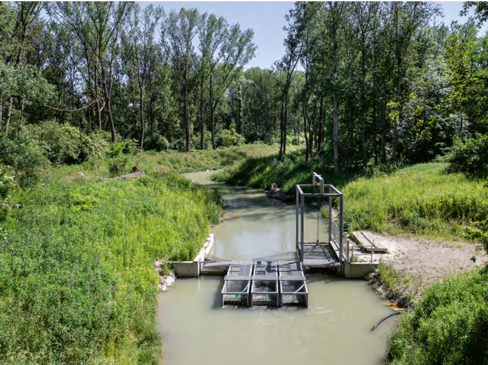
Abb. 5: Reusenanlage bei der Fischwanderhilfe Abwinden-Asten. Das Fischwehr ist hier als dreiteiliger Kasten (links im Bild) ausgeführt. Gut erkennbar die Hebevorrichtung für die im Bild eingetauchte Reuse (rechts im Bild).
