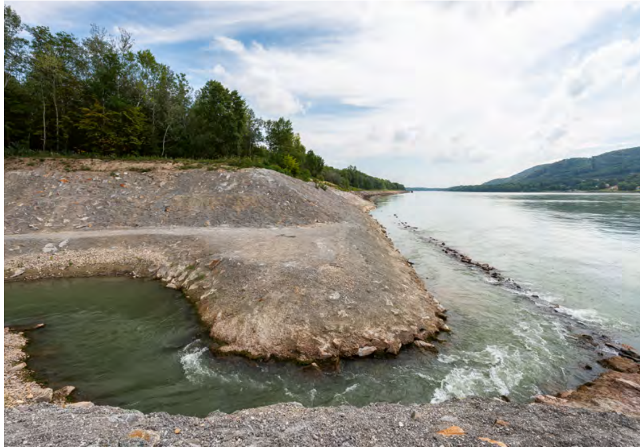
Abb. 4: Fischeinstieg der Fischwanderhilfe Greifenstein, aufgenommen bei Niederwasser. Gut erkennbar sind die Einstiegsrampe und der parallel verlaufende Steinriegel als Begrenzung zur Donau.
