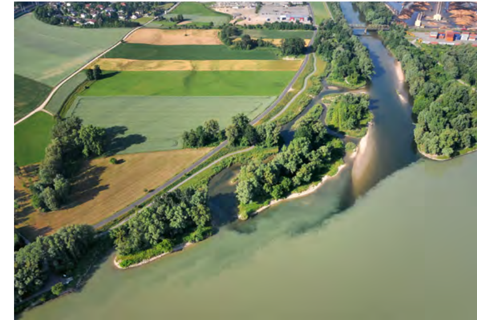
Abb. 8: Luftbild der neu gestalteten, aufgeweiteten Ybbsmündung. Die rechtsufrige Aufzweigung mit Nebengewässern und Inseln entstand auf angekauften Grundstücken. Der Radweg – ursprünglich direkt an der regulierten Strecke gelegen – wurde landeinwärts verschwenkt, um Gestaltungsfreiheit zu erlangen. Ziel der Maßnahme war es, wichtige Au- und Gewässerstrukturen als typischen Lebensraum an der Donau bzw. an der Ybbs wieder herzustellen.
