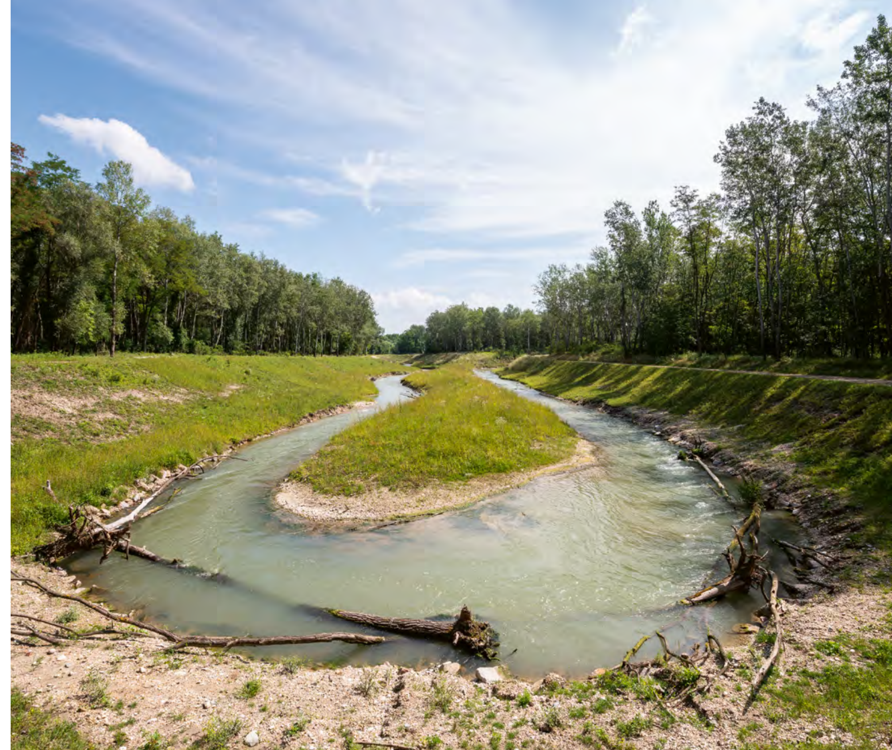
Abb. 6: Schleife bei der Fischwanderhilfe Greifenstein. Wegen der weiteren Schutzgüter im Projektgebiet und der erforderlichen Länge ergab sich diese Linienführung.
