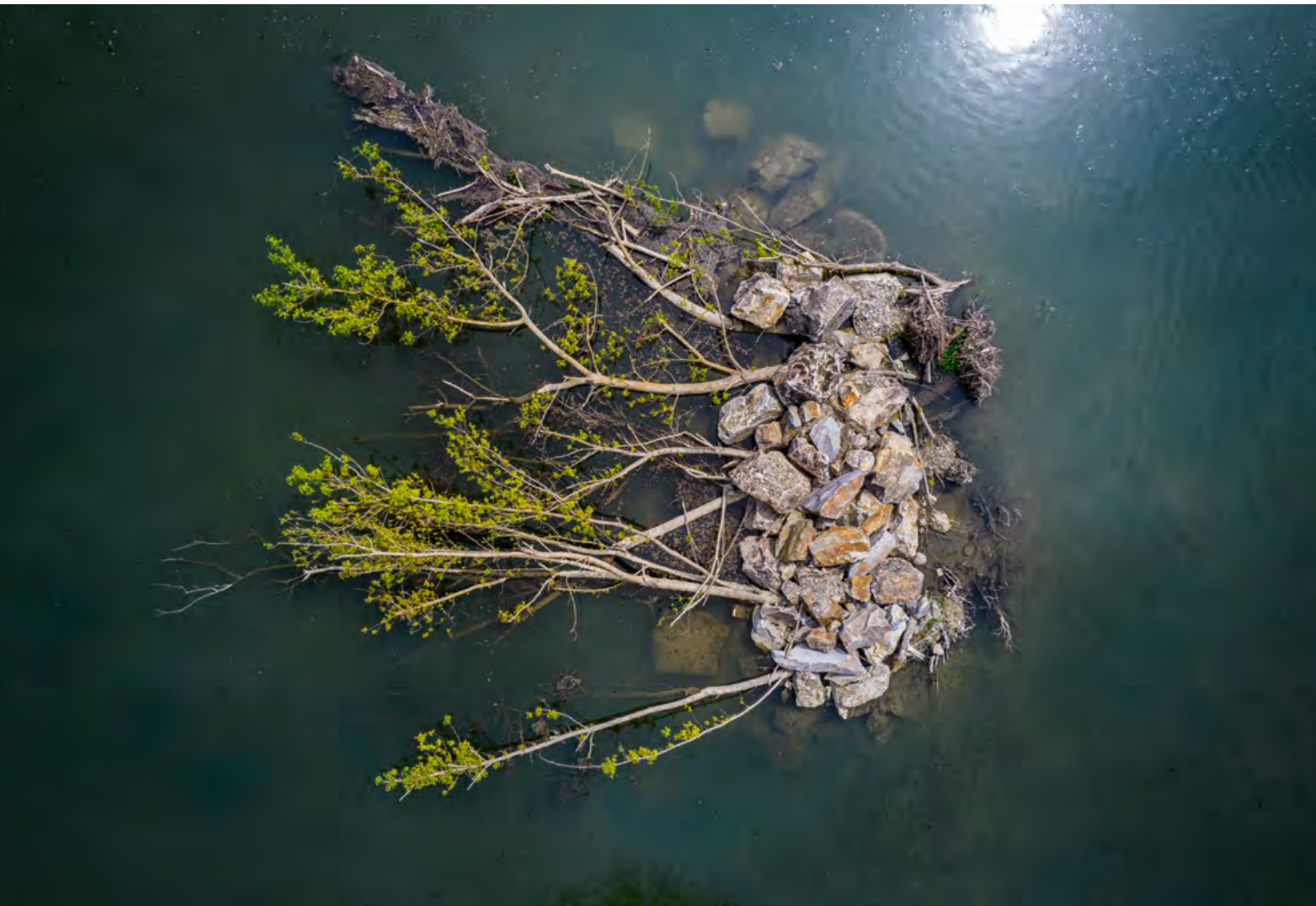
Abb. 4: Strömungsteiler im Kremsergerinne.
