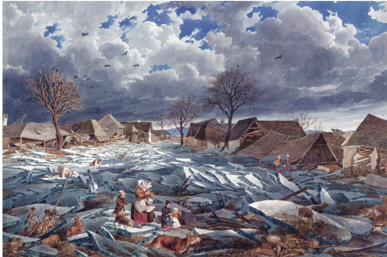
Abb. 4: Im Dorf Leopoldau im Norden Wiens wurden im Jahr 1830 die zumeist aus Holz errichteten Häuser von den Eisschollen regelrecht zerquetscht.
