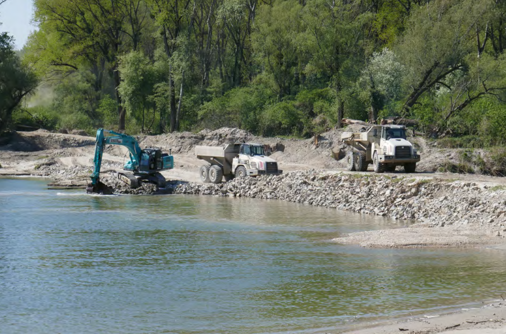
Abb. 16: Rückbau der mächtigen Mündungstraverse des Spittelauer Arms. In Summe wurden zur Wiederanbindung etwa 150.000 m 3 Wasserbausteine und Sedimente bewegt.
