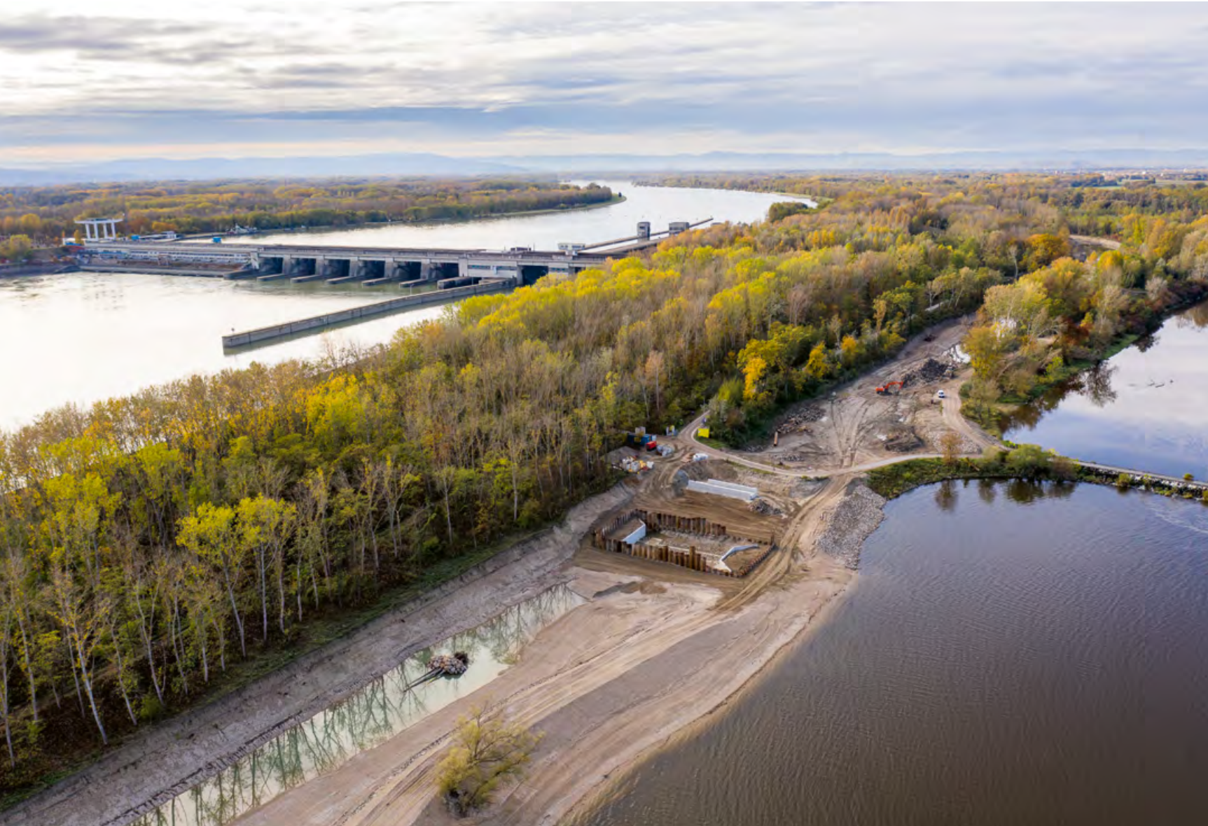
Abb. 1: Oktober 2020: Das Kraftwerk Altenwörth mit dem in Bau befindlichen neuen Nebenarm – mit Totholzstruktur, der Baugrube für die Reuse sowie einer Brücke über das Gerinne und dem Altarm im Vordergrund.
