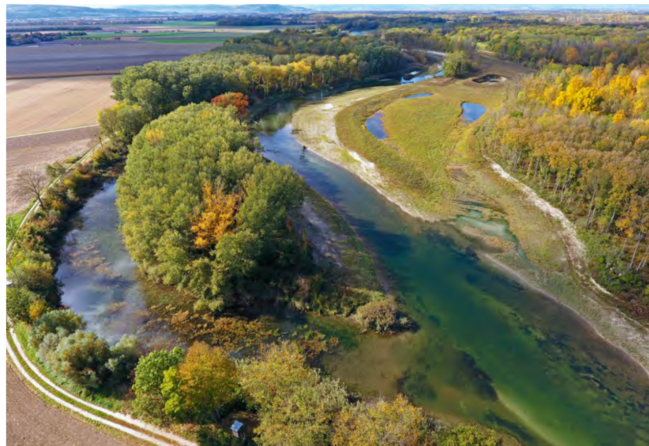
Abb. 14: Schon kurz nach Abschluss der Bauarbeiten im Jahr 2016 kommt es flächendeckend zur Naturverjüngung mit Weiden und Pappeln in den abgesenkten Aubereichen.
