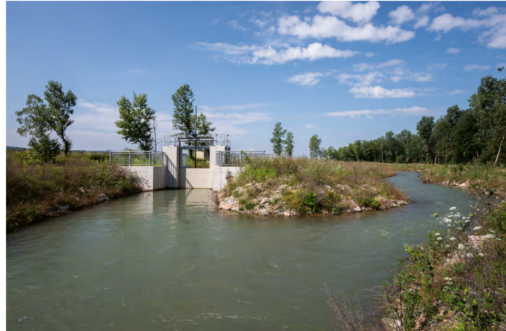
Abb. 6: Zusatzdotationsbauwerk mit einmündender Schleife, etwa ein halbes Jahr nach der Inbetriebsetzung. Durch das Öffnen des Zusatzdotationsbauwerkes kann die Wassermenge in der Fischwanderhilfe gesteigert werden.
