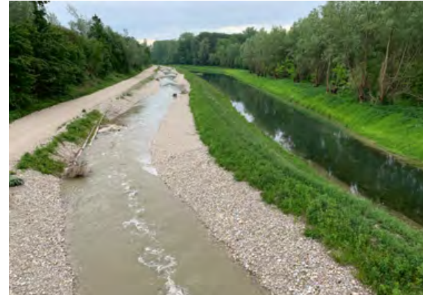
Abb. 9: Links die Fischwanderhilfe, rechts das Mitterwasser. Die Verbindung der beiden Gewässer erfolgt, im Bild nicht sichtbar, am oberen Bildrand (Blickrichtung flussab).
