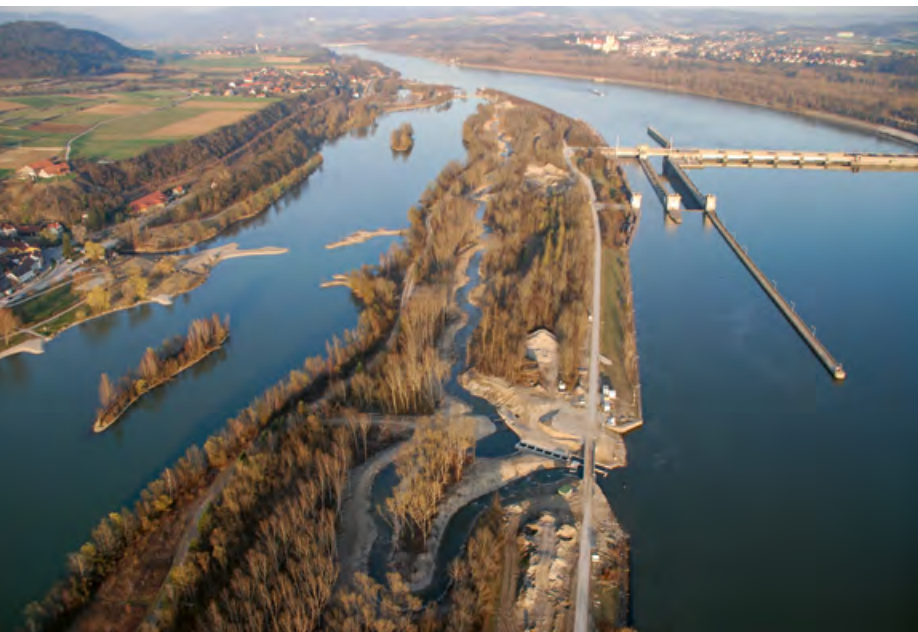
Abb. 4: Bauzustand des obersten Abschnitts der Fischwanderhilfe und des komplexen Dotationsbauwerks. Die naturnahe Fischwanderhilfe wird heute, im fertigen Zustand, unter einer neu errichteten Treppelwegbrücke dotiert und verläuft zur Gänze als naturnaher Umgehungs-bach.
