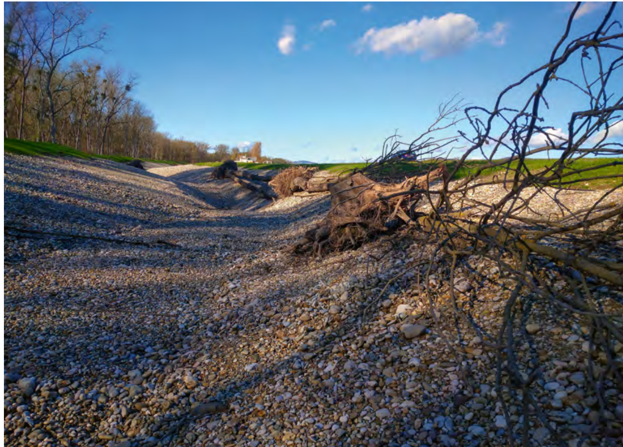
Abb. 6: Flussbettgestaltung mit Holzstrukturen: Die unter Wasser liegenden Teile der Laub-Raubäume erfüllen infolge des sich an ihnen anlegenden Treibgutes eine ähnliche Wirkung wie Buhnen: Strömunglenkung, Tiefenrinne und die Ausbildung strömungsgeschützter Buchten für aufsteigende Fische. Zugleich besitzen die Bäume für Fische eine große Bedeutung als Einstände. Zusätzlich eingebrachte Wurzelstöcke, ebenfalls mit Stahlseilen und Erdankern gesichert, unterstützen die Uferstrukturierung weiter.
