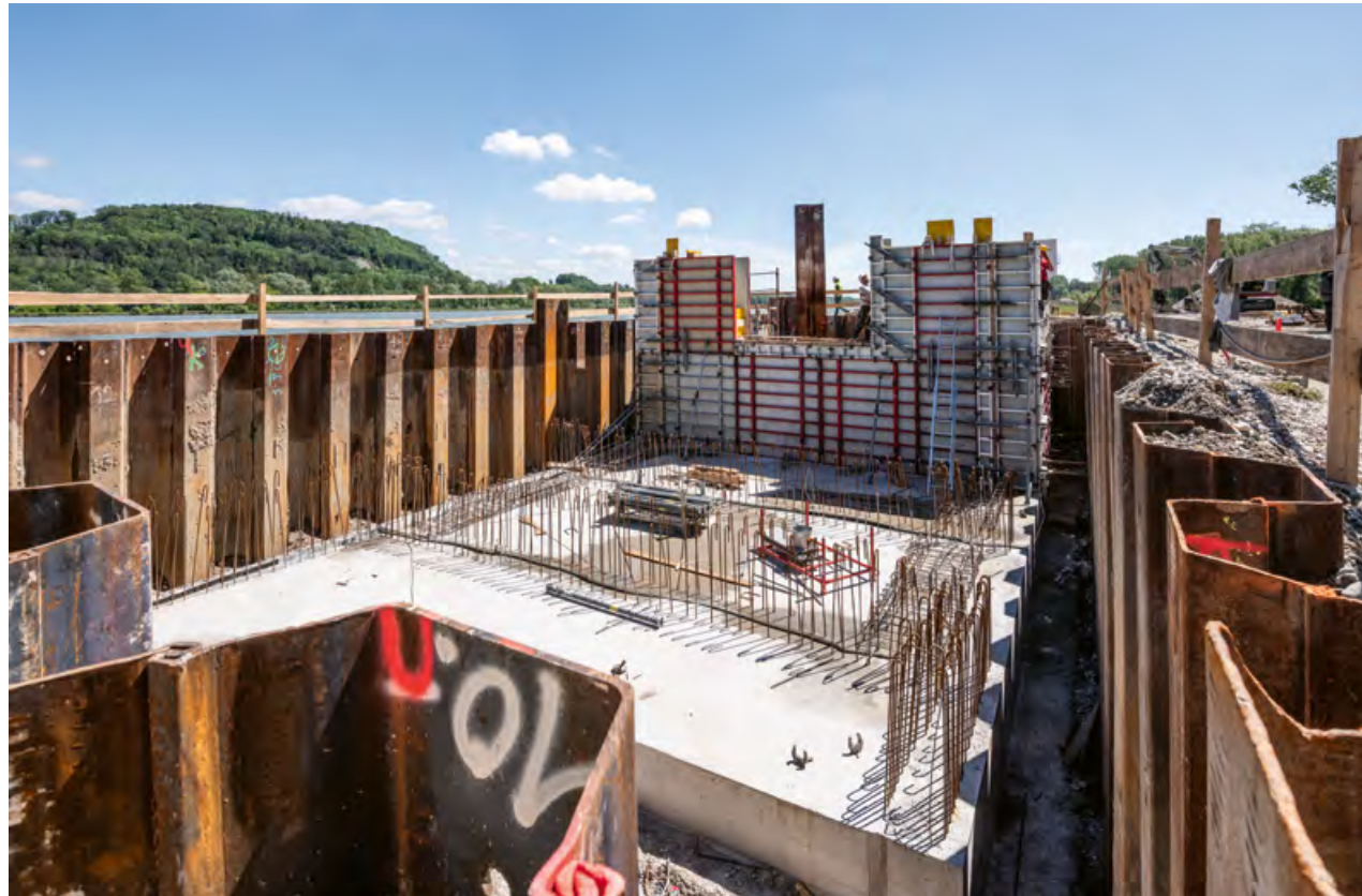
Abb. 3: Hier wird später das Wasser aus dem Kraftwerks-Staubereich – genau gesteuert – eingeleitet. Das Einlaufbauwerk der Fischwanderhilfe Abwinden-Asten während der Errichtungsphase. Nach seiner Fertigstellung wird der sichtbar bleibende Teil des Bauwerks kaum mehr etwas von seiner massiven Gesamtgröße ahnen lassen.
