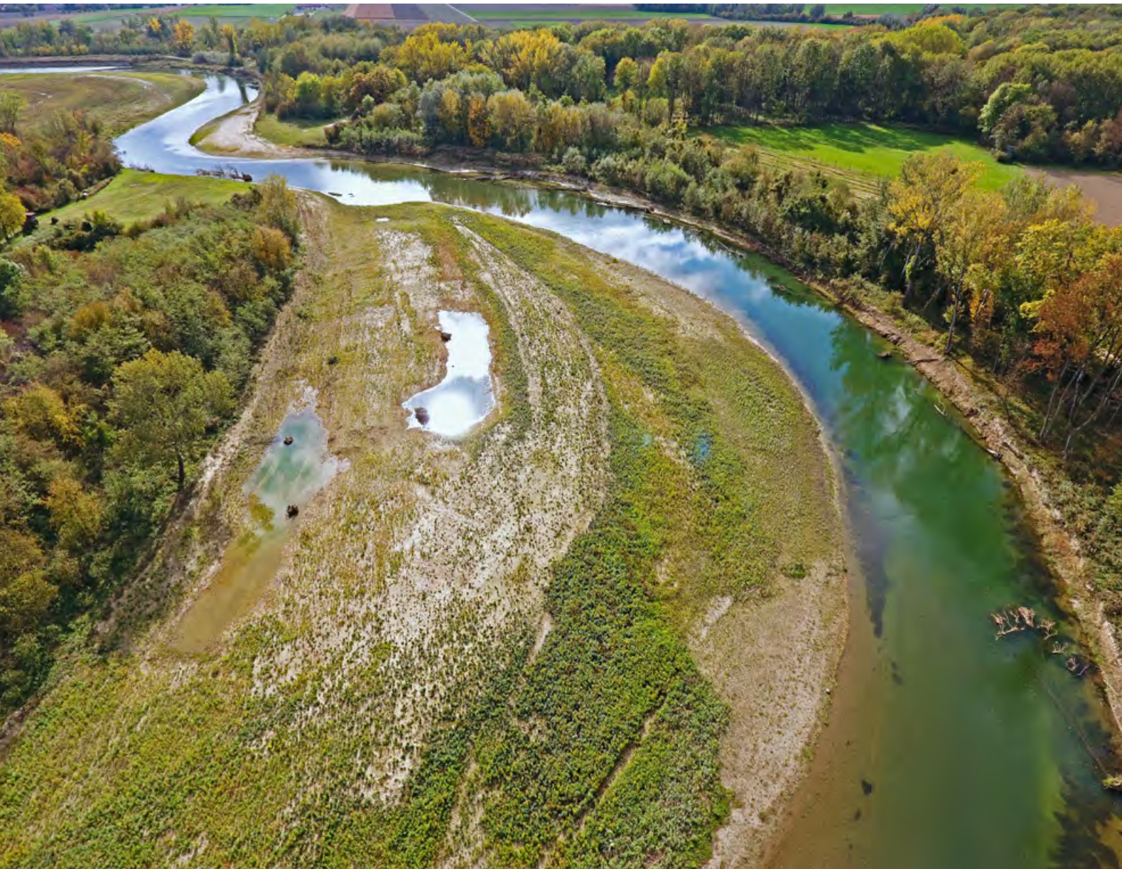
Abb. 2: Die Umlandabsenkungen an der „Neuen Traisen“ und die dort liegenden Nebengewässer werden erst ab dem einjährigen Hochwasser durchströmt, sodass niedrigere Abflüsse im Flussbett selbst die volle morphologische Dynamik entfalten können; die Außenufer sind durch Raubbäume strukturiert.
