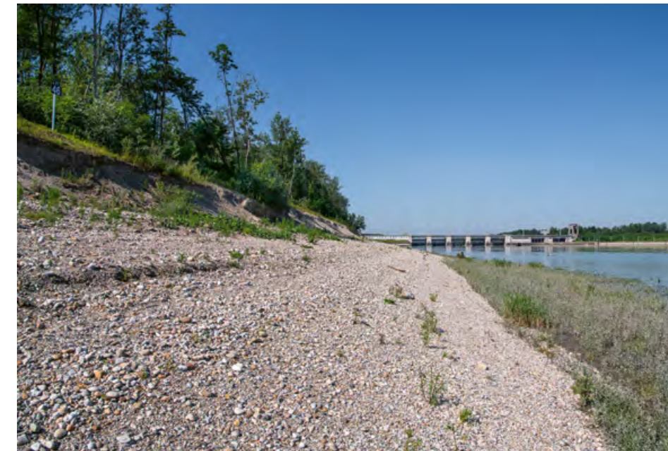
Abb. 7: Fertig gestellter Uferrückbau bei Markttau, am rechten Ufer. Blickrichtung Donau aufwärts, mit dem Kraftwerk Ottensheim-Wilhering im Hintergrund, August 2018.
