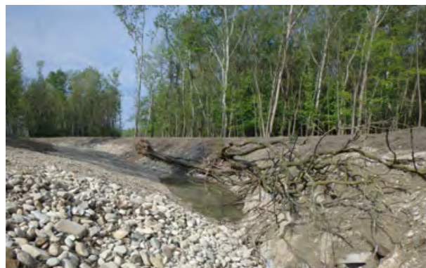
Abb. 5: Kurz vor der Flutung: Blick in das fertig strukturierte Gerinne der Fischwanderhilfe mit fixiertem Raubbaum. Der im Vordergrund sichtbare Kolk hat sich mit Wasser gefüllt.
