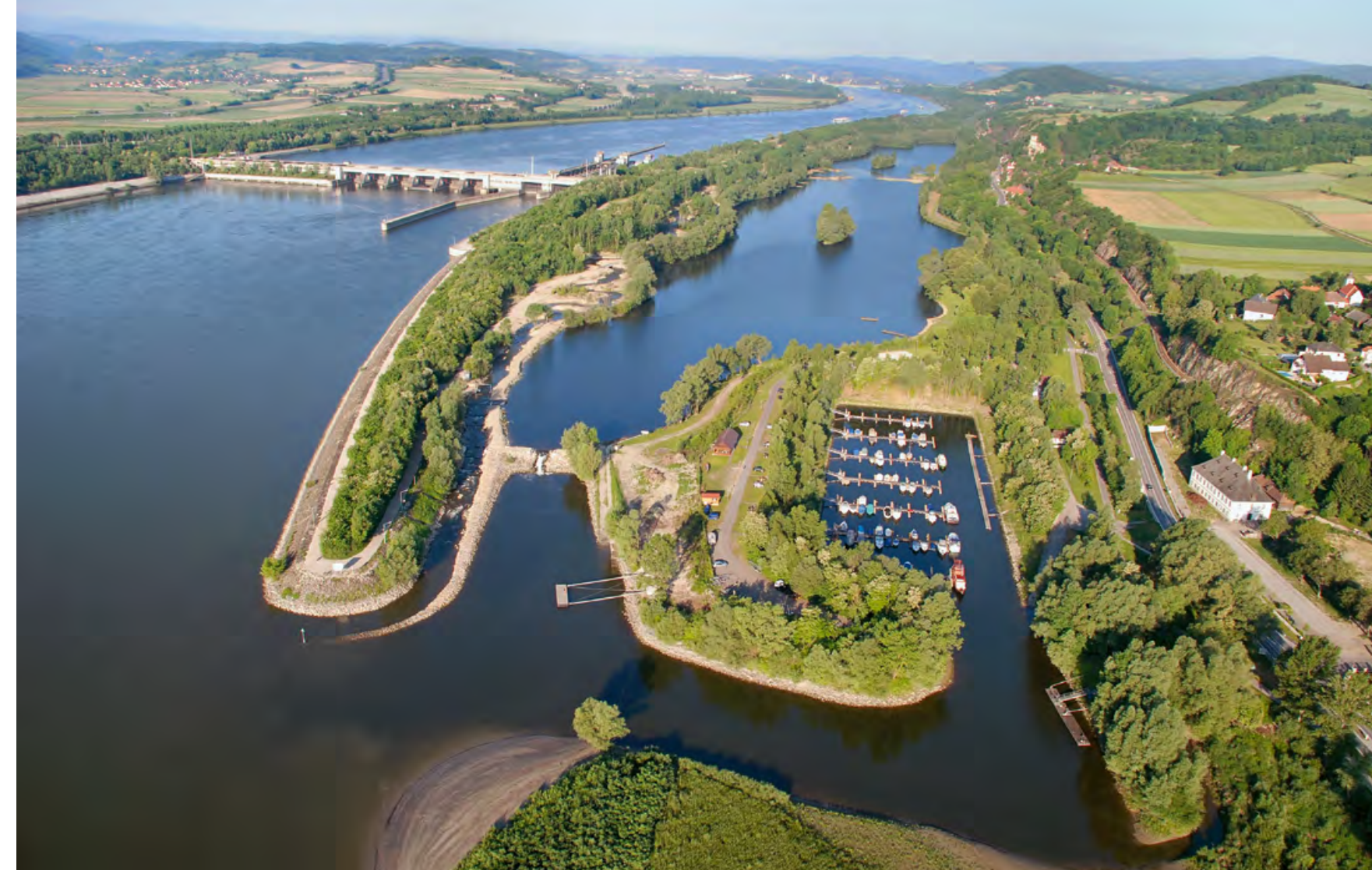
Abb. 2: Mündungsabschnitt der Fischwanderhilfe am „Sporn“ zwischen Donau und Luberegger Altarm. Blick Donau stromauf, links Donaukraftwerk Melk, rechts Luberegger Altarm und Sportboothafen Emmersdorf.
