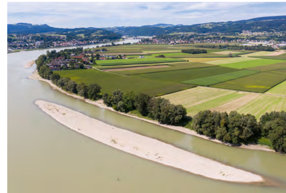
Abb.3: Eine fertiggestellte Kiesinsel parallel zum Uferverlauf der „Ybbs-Scheibe“ im März 2020. Links im Hintergrund ist die Einmündung der Ybbs zu sehen.
