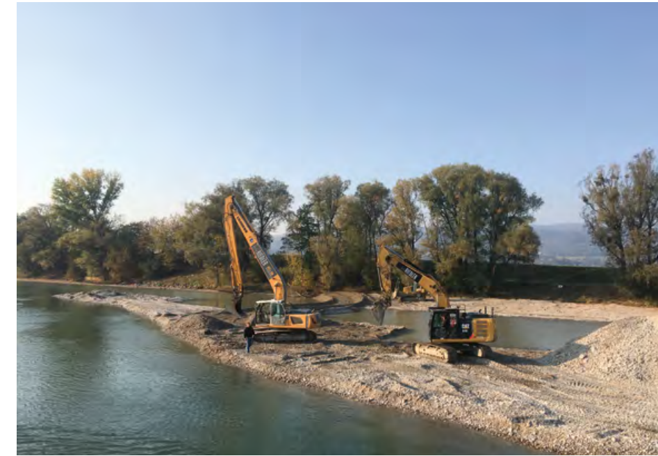
Abb.2: Die endgültige Strukturierung und Gestaltung der aufgeschütteten Kiesinseln erfolgte mit Landgeräten im Herbst 2018.
