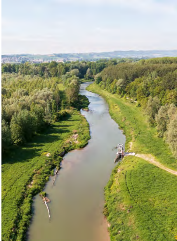
Abb. 6: Luftaufnahme der Fischwanderhilfe im unteren Bereich. Der gewundene Verlauf ist gut erkennbar, ebenso der ursprüngliche sehr gerade Verlauf der Ufer ist am Baumbestand gut zu erkennen. Die Reuse ist am linken Ufer (im Bild rechts) zu sehen.
