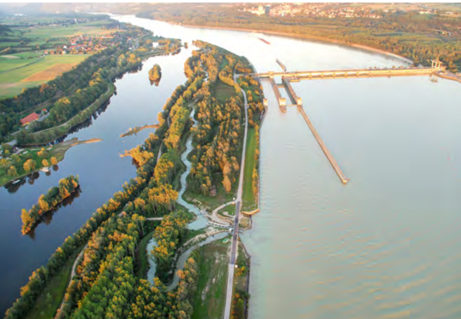
Abb. 3: Dotationsbauwerk und Verlauf der Fischwanderhilfe. Links im Bild die mit Kies-Aushub geschaffenen Ufer- und Inselstrukturen im Luberegger Altarm bei der Weitenbach-Mündung.
