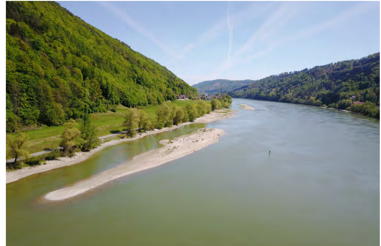
Abb. 4: Uferstrukturierung und geschüttete Inseln in der Stauwurzel des Donaukraftwerks Aschach als Beispiel für gewässerökologische Maßnahmen im Rahmen von LIFE „Blue Belt Danube-Inn“.
