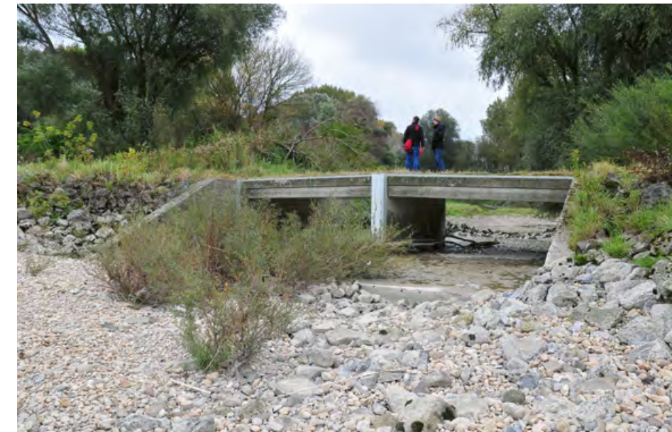
Abb. 15: Die starren Kastendurchlässe werden entfernt, um das Wasser ungehindert durchfließen zu lassen.
