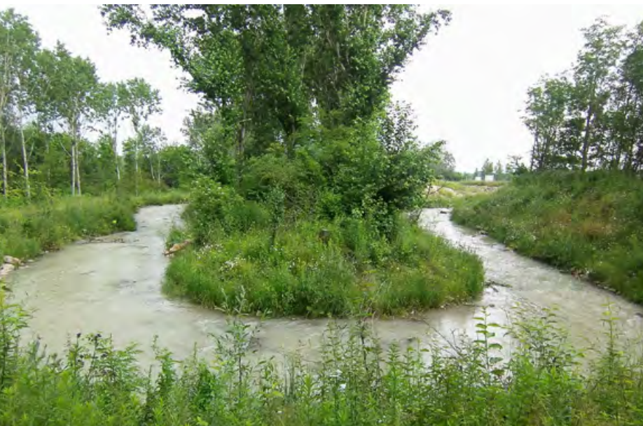
Abb. 7: Schleife der Fischwanderhilfe Kraftwerk Melk im Juni des Folgejahres. Die Bepflanzungsarbeiten mit ökologisch vielfältigem Saatgut und die Verarbeitung von Weidensteckhölzern und Wurzelstöcken zeigt einen schnellen Erfolg. Ziel war es, einen standorttypischen Pflanzenbewuchs rasch aufzubauen.
