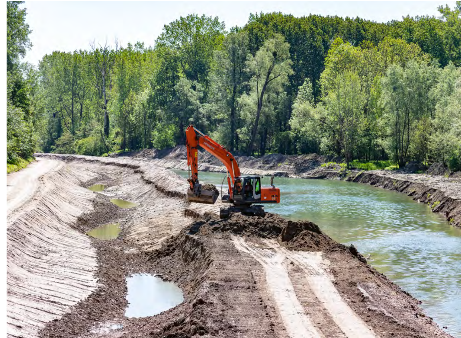
Abb. 4: Bauarbeiten im Bereich des Mitterwassers bei der Fischwanderhilfe Abwinden-Asten. In diesem Bereich verlaufen die Gerinne parallel. Etwas flussab wurde die Verbindung dieser beiden Gewässer hergestellt, die nun das Mitterwasser auch oberstromig mit der Donau verbindet.
