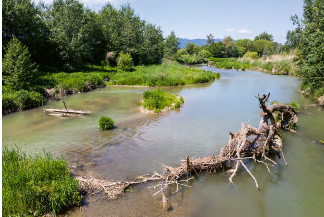
Abb. 3: Fischwanderhilfe Kraftwerk Ottensheim-Wilhering: Uferaufweitung und naturnahe Ausgestaltung des Umgehungsbaues mit Kiesstrukturen und Totholzstrukturen erschaffen bisher kaum vorhandenen Fischlebensraum und Laichhabitate.
