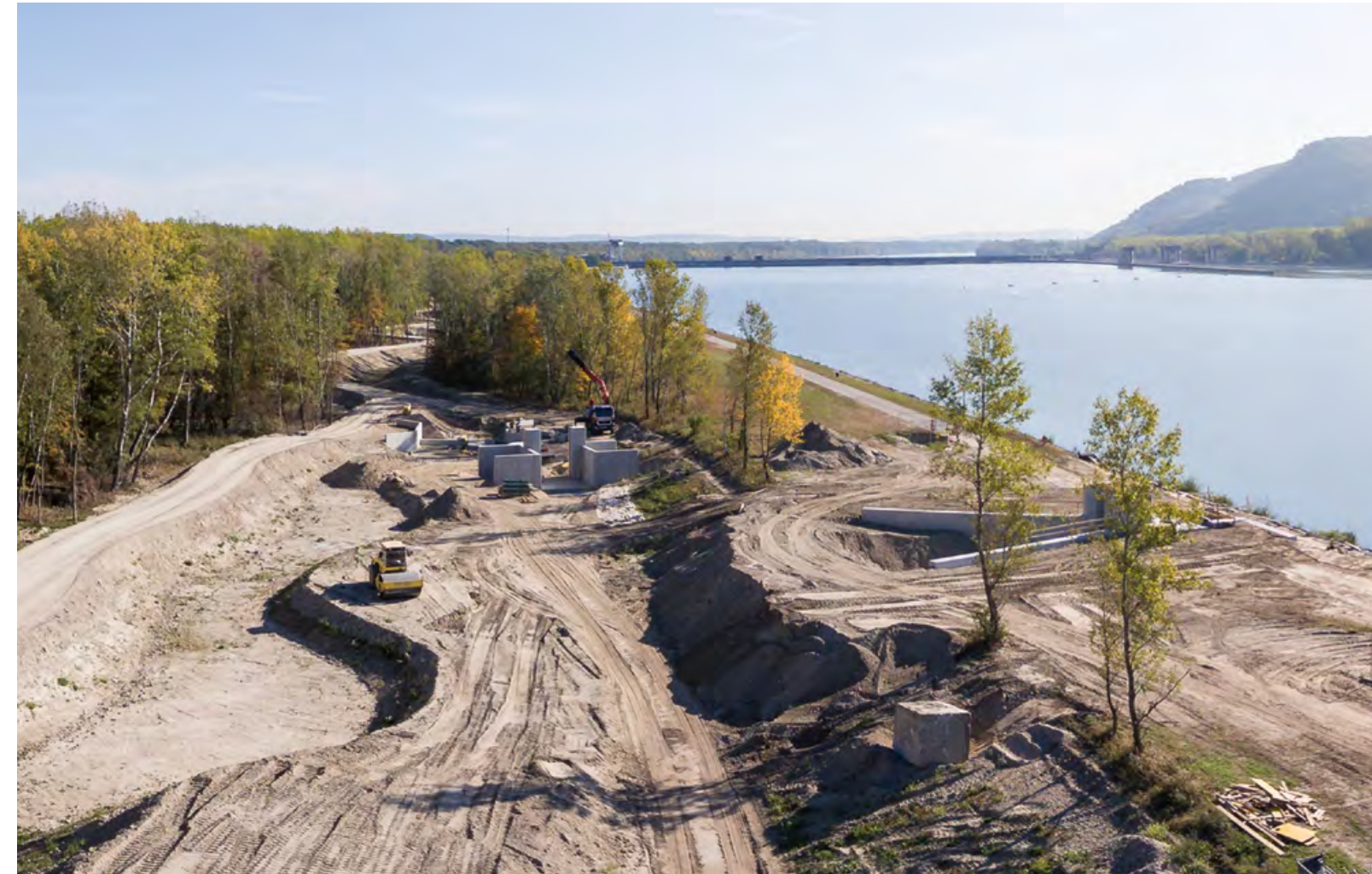
Abb. 3: Der Ausstiegsbereich der Fischwanderhilfe Greifenstein im Bau: Das Dotationsbauwerk, rechts im Bild, und das Zusatzdotationsbauwerk, in der Bildmitte zu sehen, sind bereits fertiggestellt.
