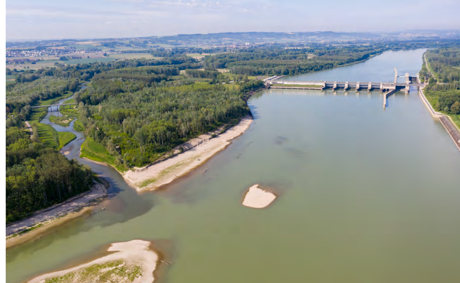
Abb. 5: Luftaufnahme der Mündung in die Donau. Flussauf der Mündung wurde das steile, mit Steinen gesicherte Ufer abgeflacht. Flussab der Mündung befindet sich der bereits vorab hergestellte Nebenarm Markttau. Im Hintergrund befindet sich das Kraftwerk Ottensheim-Wilhering.
