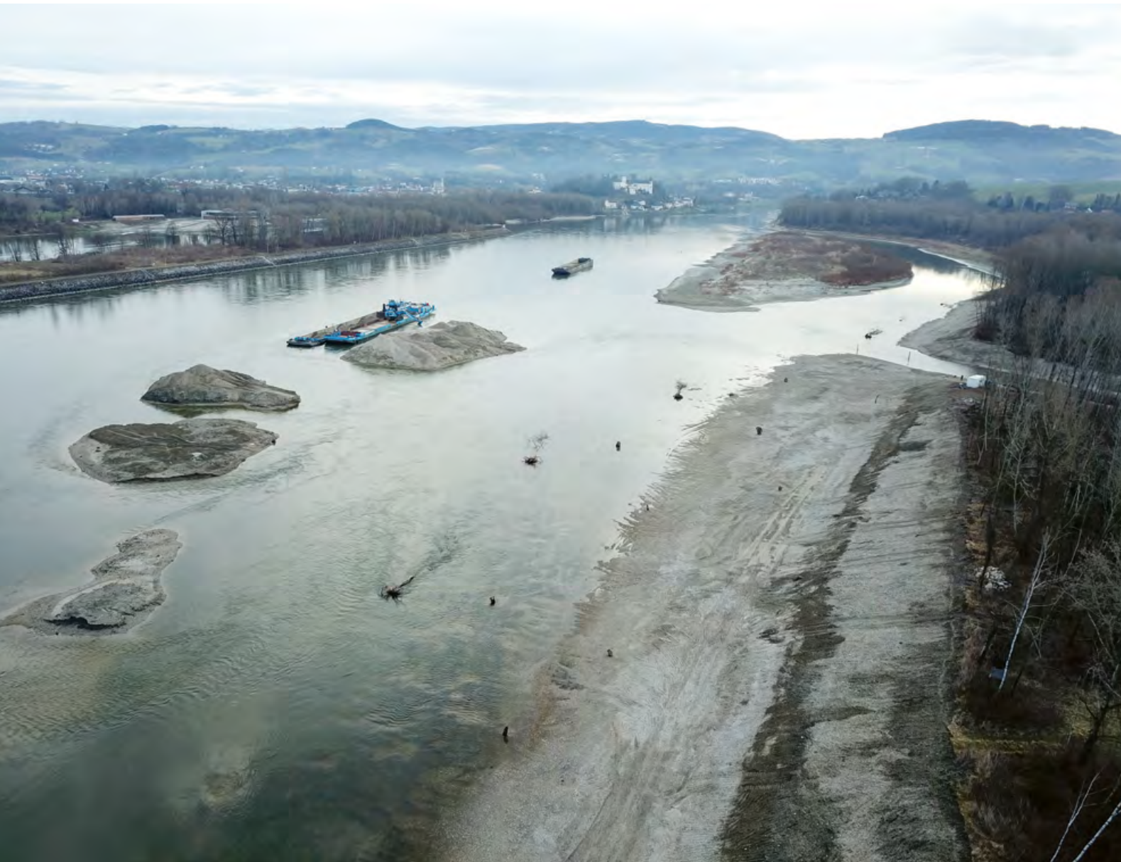
Abb. 6: Abtransport von ausgebaggertem Material per Schiff. Im Bild rechts ist der Einstieg in die Fischwanderhilfe Ottensheim-Wilhering zu sehen. Frühjahr 2018, Blickrichtung flussabwärts.
