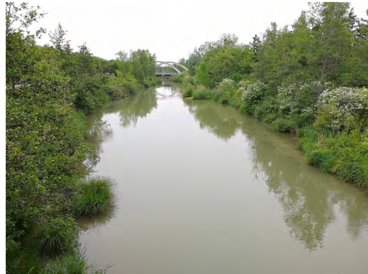
Abb. 7: Fünf Holzbogenbrücken, wie hier jene bei der Strebersdorfer Straße, setzen deutliche Markierungen in die Landschaft.
