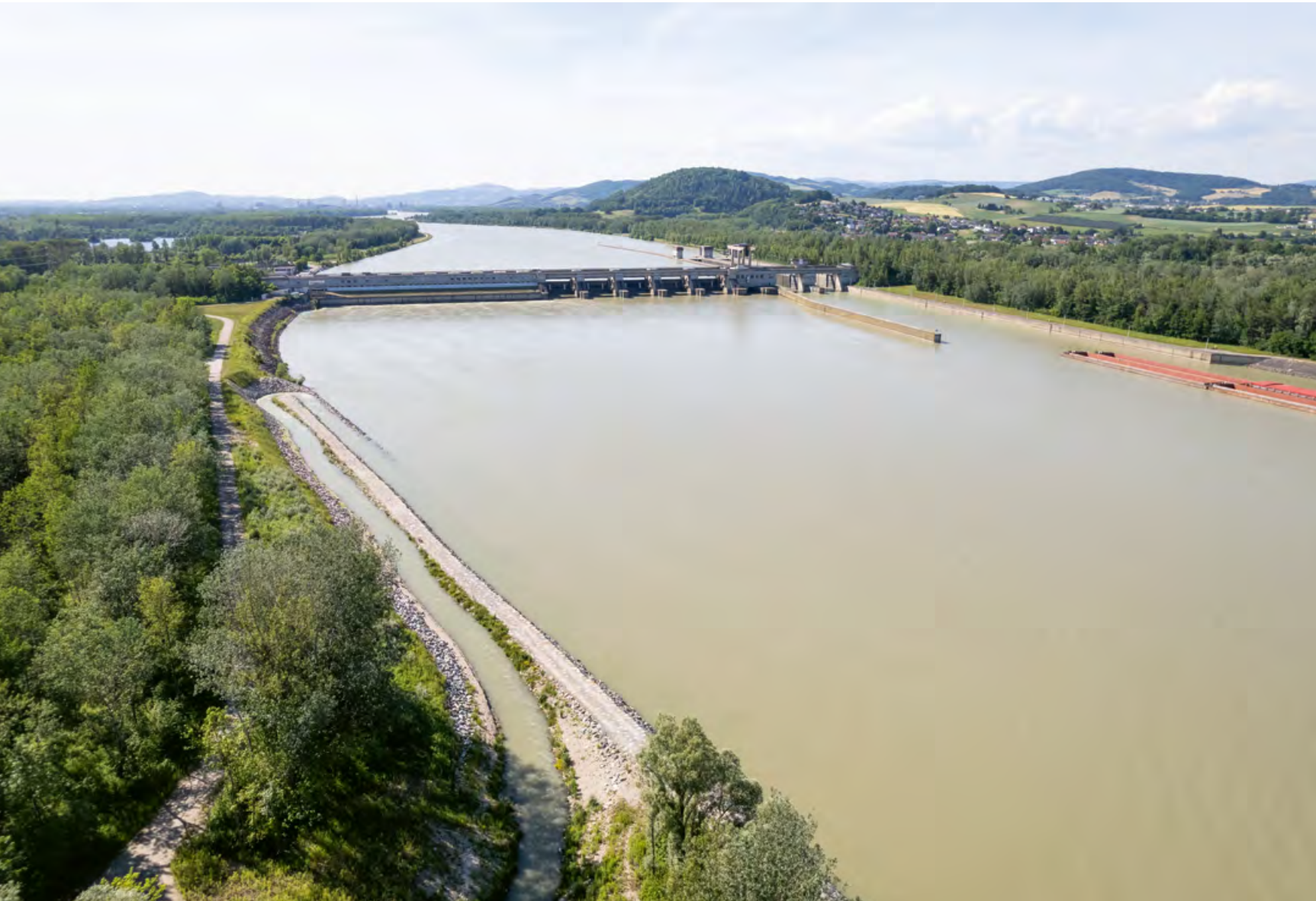
Abb. 4: Blick auf die Mündungsrampe der Fischwanderhilfe bei Abwinden-Asten: Bei Niedrigwasser liegt der Einstieg, seitlich von der Donau durch einen niedrigen Damm getrennt, am unteren Ende der Rampe. Bei höheren Abflüssen, wie auch hier im Foto, rückt der Einstieg mit steigendem Wasserspiegel entlang der Rampe immer weiter flussauf, wobei er dank der immer niveaugleichen Mündung und einer gut wahrnehmbaren Leitströmung für aufstiegswillige Fische stets gut aufzufinden ist.
