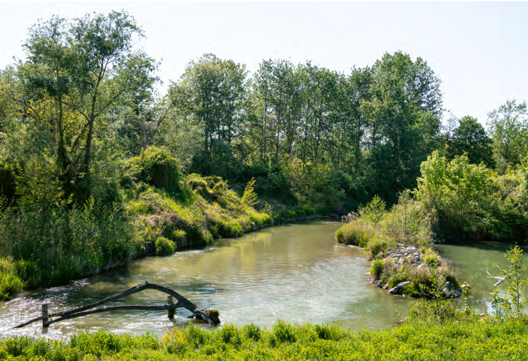
Abb. 3: Mündung des gänzlich neuen Teils der Fischwanderhilfe in den Altarm bei Brandstatt. Ein Teil des Altarmes wurde als Fischgewässer erhalten und ist mit einem Riegel zur Fischwanderhilfe abgegrenzt (rechts im Bild).
